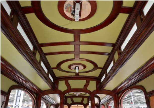
Bei der Verkabelung der Innenraumbeleuchtung
